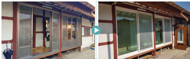
Kook Joongkwang住宅门窗维修前 Kook Joongkwang住宅门窗维修后
