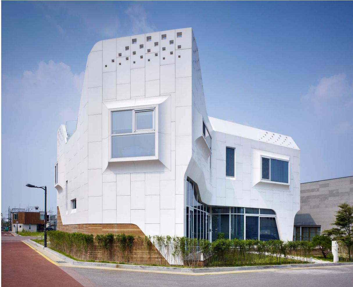
*Con la costruzione del **Pan-gyo Residence** realizzato dello studio di architettura coreano **Office 53427**, per la prima volta in Corea è stata realizzata una **facciata in HI-MACS®**. Le proprietà del materiale sottolineano in modo magistrale gli obiettivi dello studio di architettura, che mirava a utilizzare nuovi materiali e nuove tecnologie per contrastare il paesaggio architettonico coreano, caratterizzato da uno stile omogeneo e da un design monolitico.*
