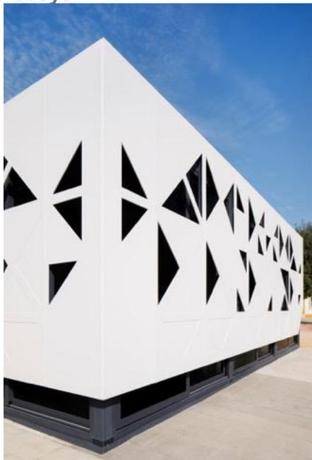
Le fabricant Horta & Veríssimo a ensuite ajouté sur ce bâtiment un mur-rideau ventilé, élaboré en Solid Surface HI-MACS®, afin d'apporter de l'ombre à la façade en verre tout en assurant une ventilation optimale. Ce mur-rideau est essentiellement constitué de panneaux HI-MACS® dans la tonalité éclatante Alpine White : 19 panneaux de 3,680 mm x 1,350 mm x 12 mm, cinq panneaux de 3,680 mm x 910 mm x 12 mm et neuf panneaux de 3,680 mm x 760 mm x 12 mm.
