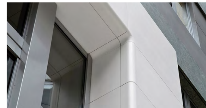
Dass hier HIMACS zum Einsatz kam, ist der Tatsache zu verdanken, dass man mit diesem Material perfekt „weiche“ Formen, z.B. abgerundete Ecken gestalten kann.
