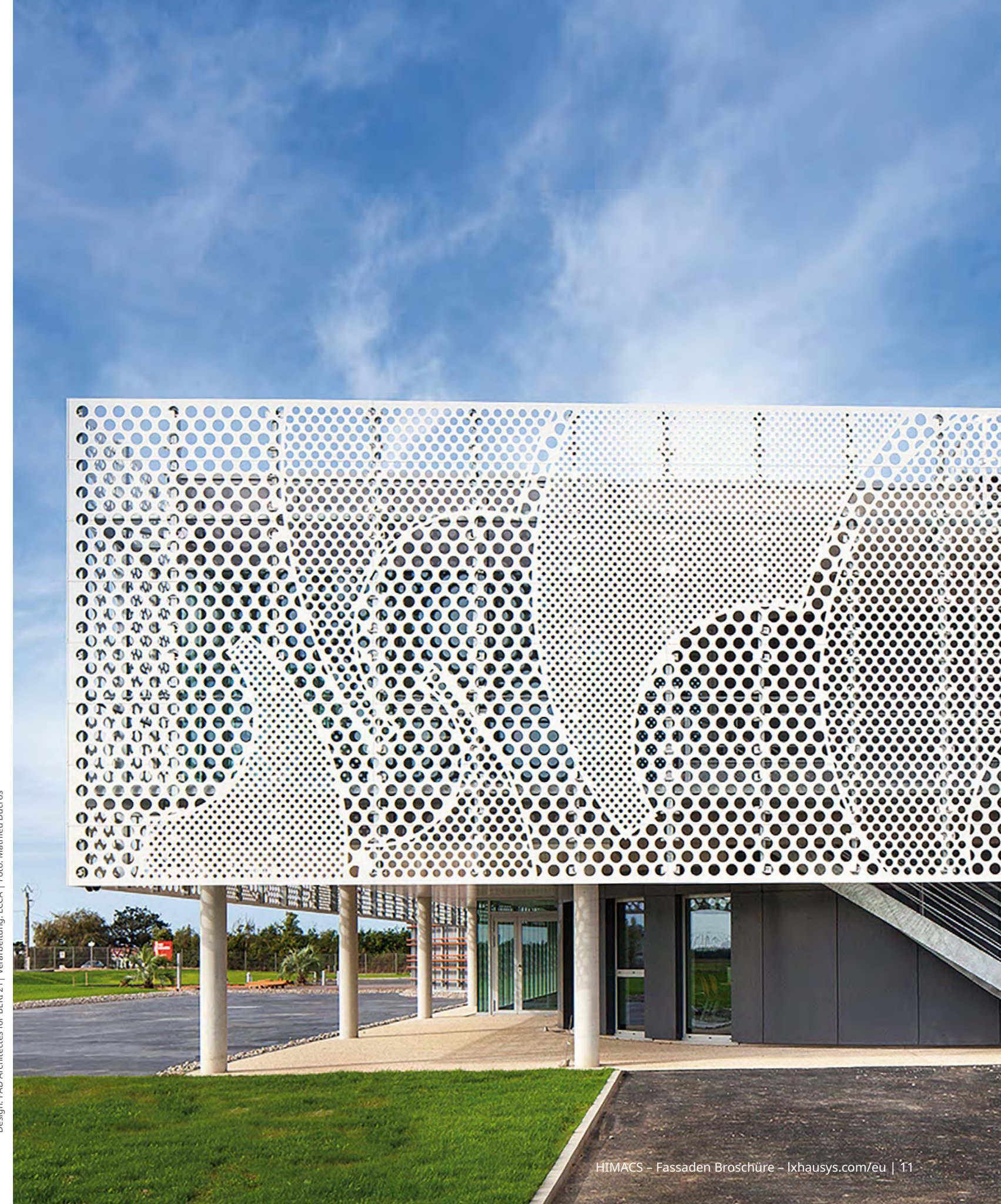
Design: PAD Architectes for BERRI 21 | Verarbeitung: LCCA | Foto: Mathieu Ducros
