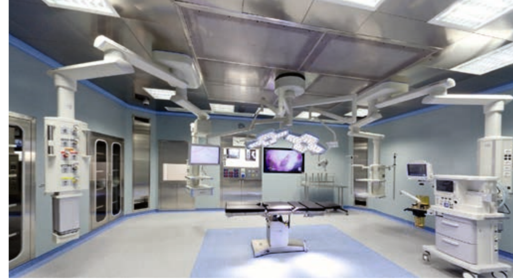
Operating Theatre At Casa Di Cura San Camillo Brescia, Italia | HIMACS sistema di pareti prefabbricate asettiche: MED s.r.l. | Fabbricazione: 3MC s.r.l.
